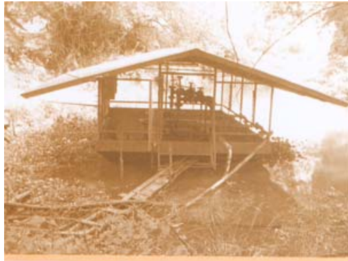
รูปที่ 34 เครื่องสูบน้ำคืบติดตั้งอยู่บนแพลอย
